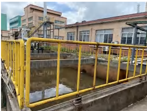
厂区雨水收集池
