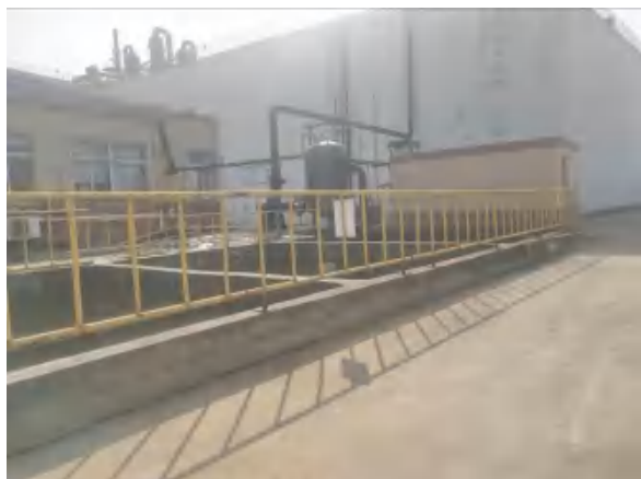
事故废水收集池
