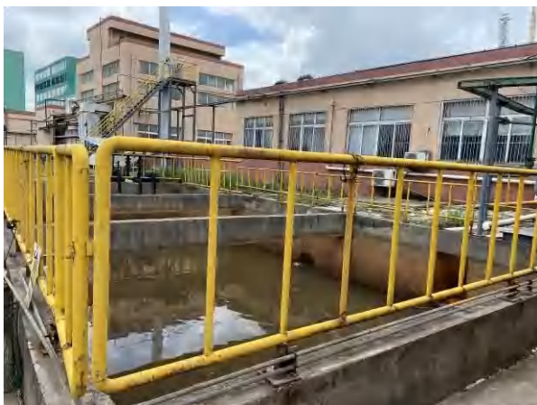
厂区雨水收集池
