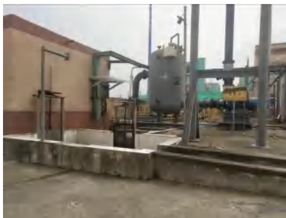
厂区雨水排放口
