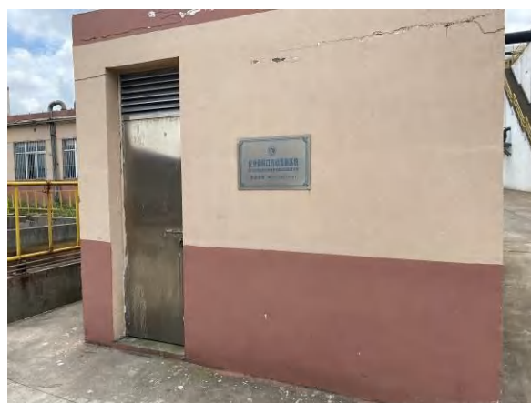
雨水排放口及自动监测房
