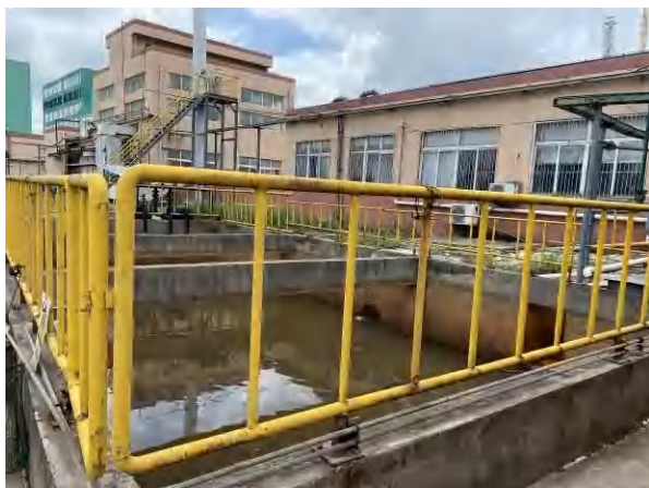
厂区雨水收集池
