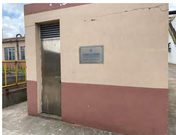
雨水排放口及自动监测房
