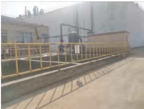
事故废水收集池
