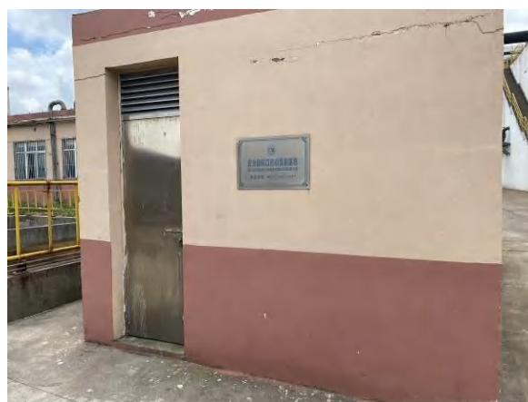
雨水排放口及自动监测房
