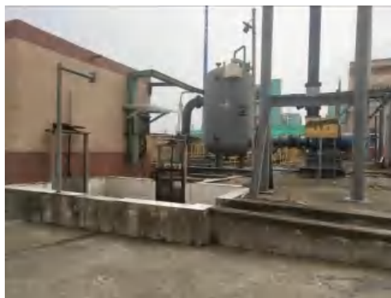
厂区雨水排放口
